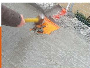
8/ Après coulage du béton et séchage de la dalle, casser le couvercle
